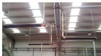
Referencia: MOL-071 CALEFACCION A GAS POR TUBO RADIANTE Año: . Marca: .
