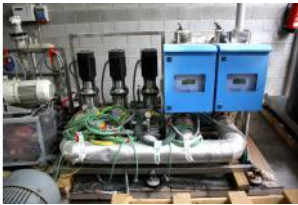
Referencia: BPS-025 GRUPO DE 3 BOMBAS CON 2 GRUPOS... Año: CRN 10-05 A-FGS-G-E-HQQE Marca: GRUNDFOS
