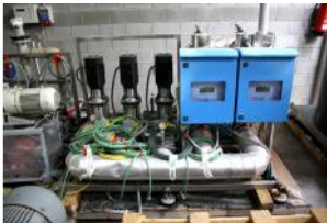
Referencia: BPS-025 GRUPO DE 3 BOMBAS CON 2 GRUPOS... Año: CRN 10-05 A-FGS-G-E-HQQE Marca: GRUNDFOS
