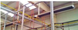
Referencia: MOL-068 CALEFACCION A GAS POR TUBO RADIANTE Año: . Marca: .
