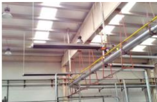
Referencia: MOL-066 CALEFACCION A GAS POR TUBO RADIANTE Año: . Marca: .
